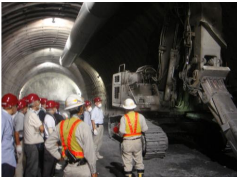
▲ 行き止まりのトンネルと掘削重機
